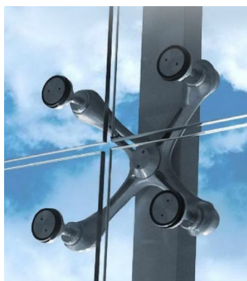
6-rasm. Spayderli fasad tizimi sxemasi va ko'rinishi
